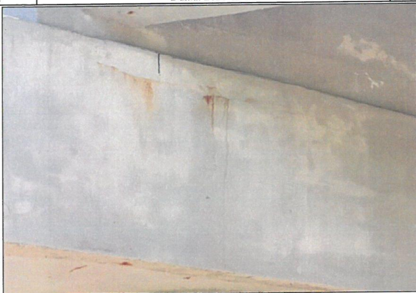
Fot. 9 Fot. 9 Odspojenia betonu. otuliny betonowej oczepu.
