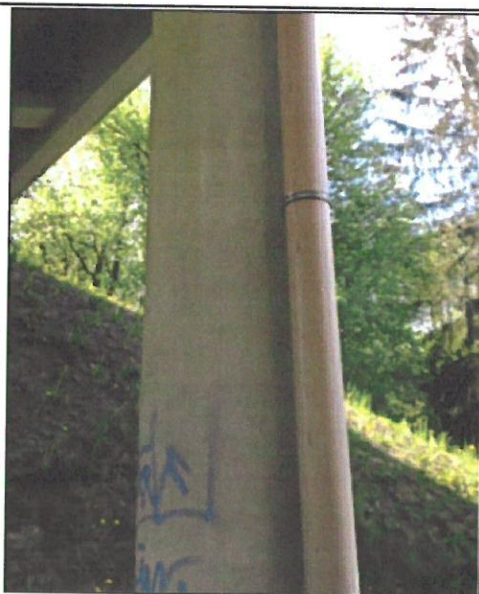
Fot. 12 Fot. 12 Rysy podłużne/odspojenia betonu filara skrajnego nad podporą P3, strona prawa.
