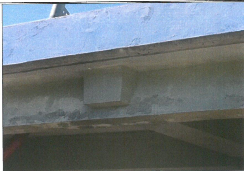
Fot. 10 Fot. 10 Zawilgocenia i przebarwienia betonu dźwigara skrajnego na prześle 2, strona lewa.
